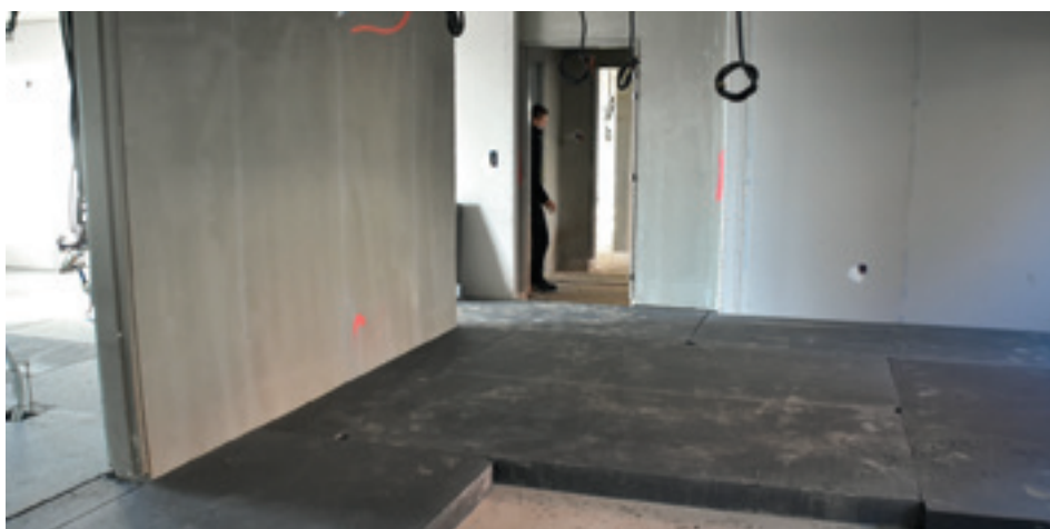
Pose de Solichape® Ultra en 120mm
