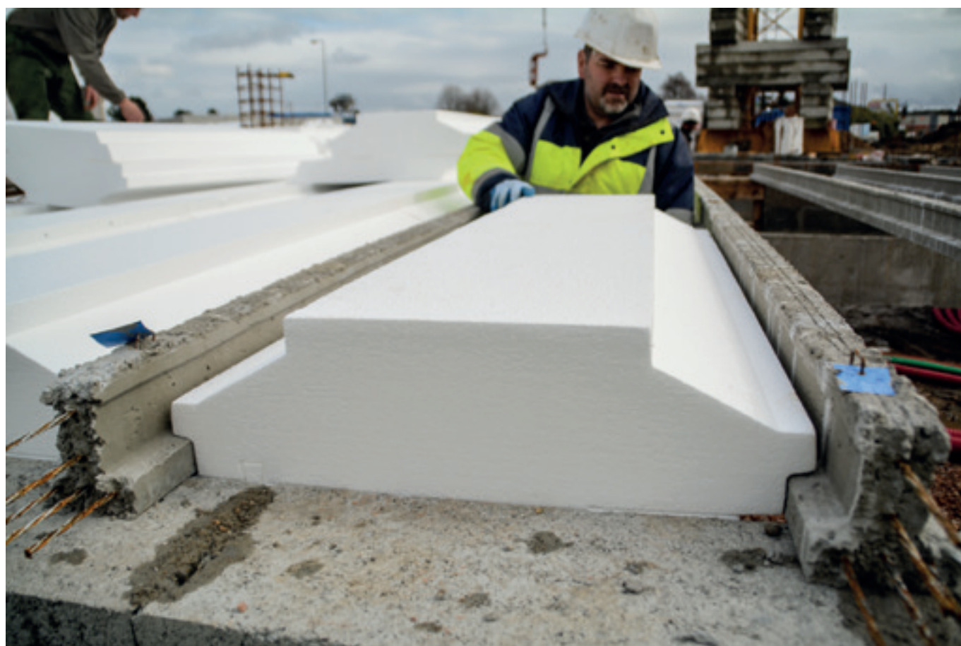
Exemple de montage sur poutrelle précontrainte
