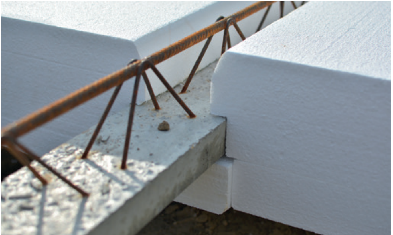
Exemple de montage sur poutrelle trellis
