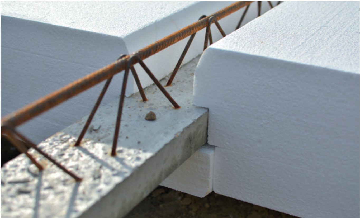
Exemple de poutrelle trellis
