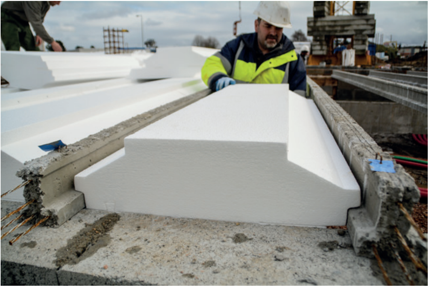
Exemple de poutrelle précontrainte
