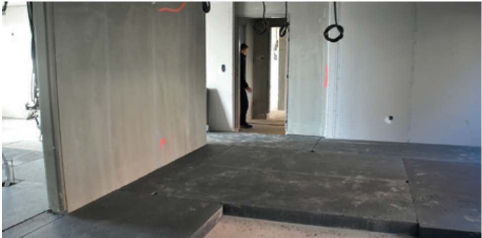
Pose de Solichape® Ultra en 120mm
