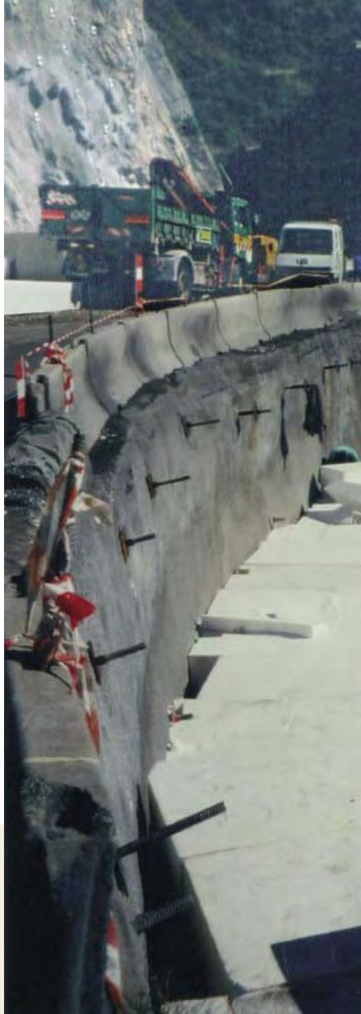
Photo 17 : montage du remblai contre une paroi clouée
