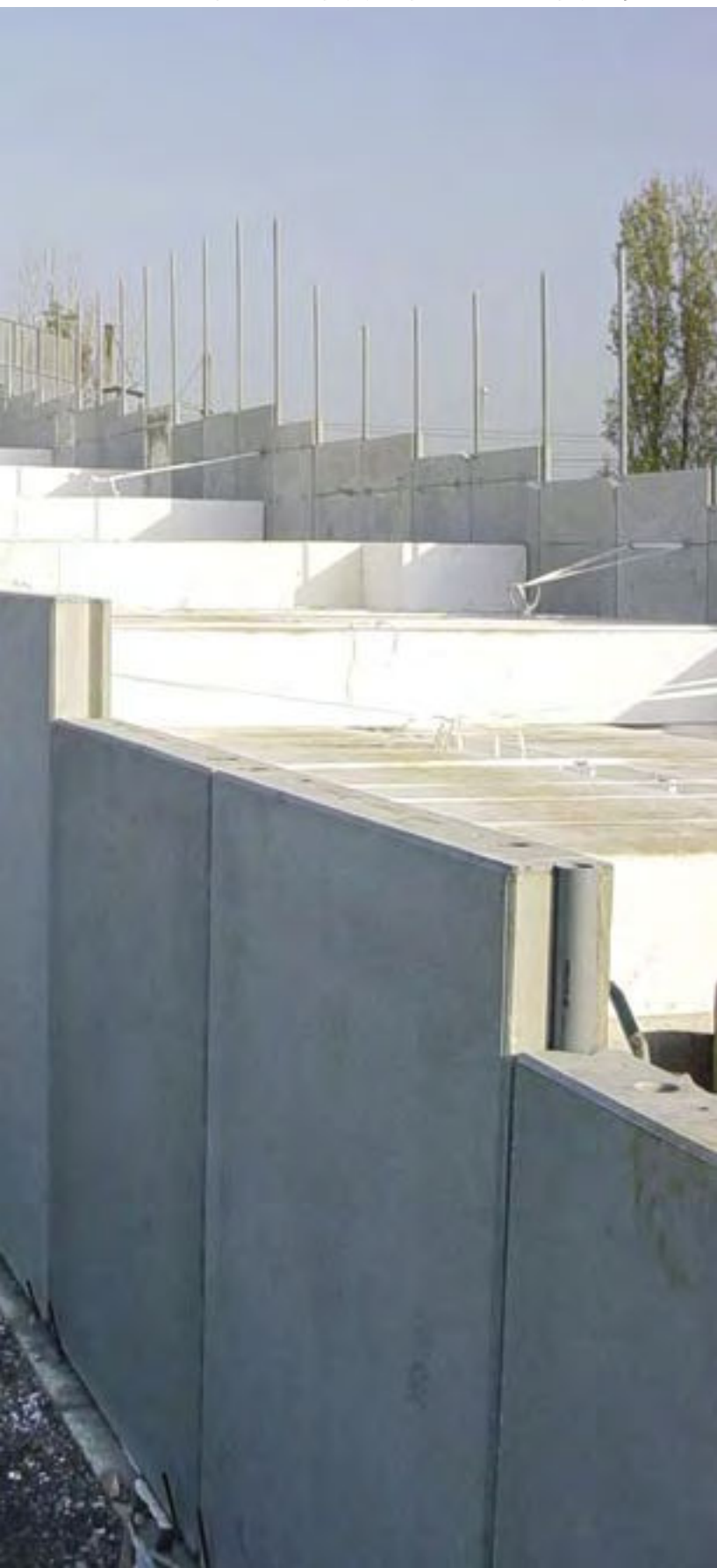
Photo 19 : protection du polystyrène par éléments béton préfabriqués
