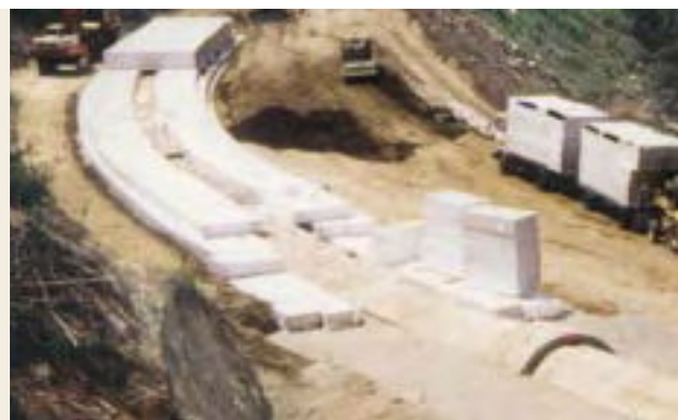
Photo 7 : remblai allégé sur une conduite forcée
