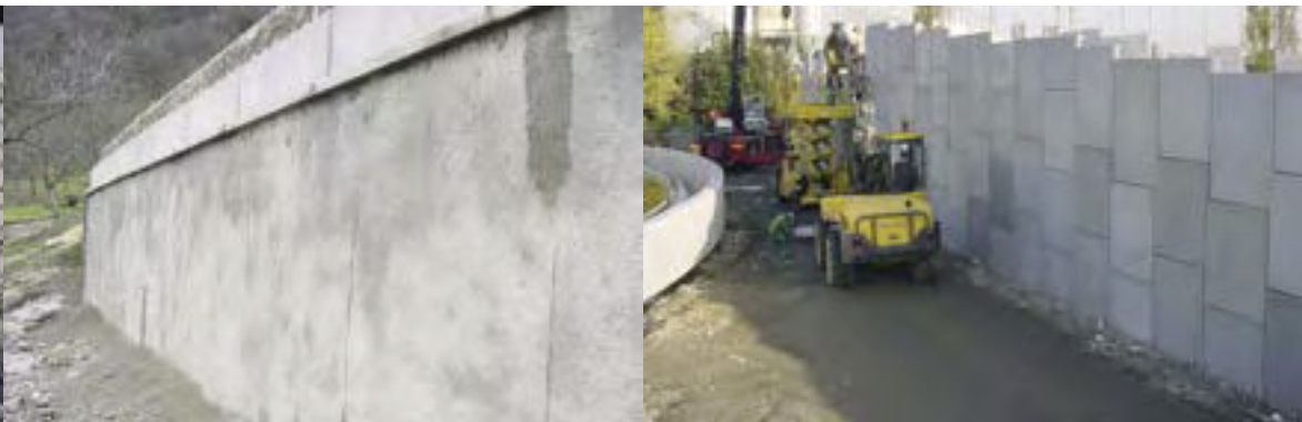
Photo 12 : parement en béton projeté
