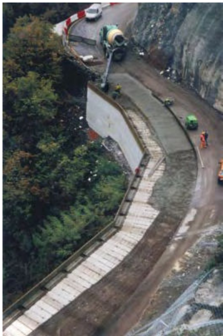
Photo 18 : bétonnage de la dalle de répartition.
