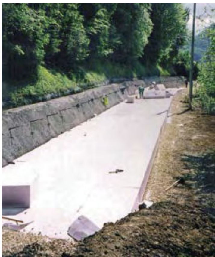
Photo 5 : réparation d'un glissement de terrain sur pente
