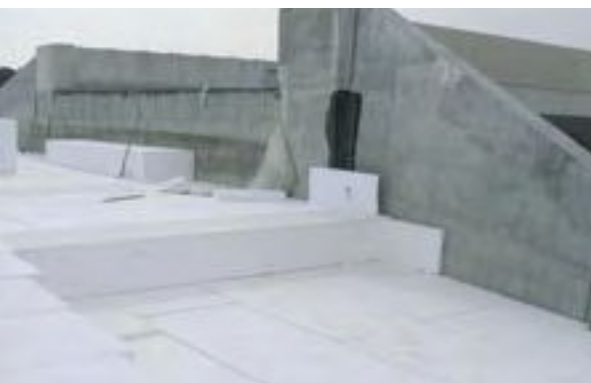
Photo et figure 2 : allègement d'un remblai d'accès à un pont
