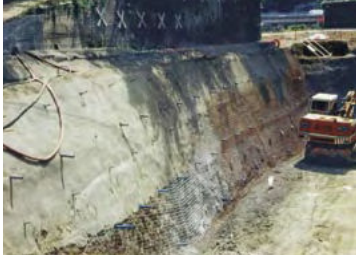
Photo 4 : exemple de confortement amont par paroi clouée.
