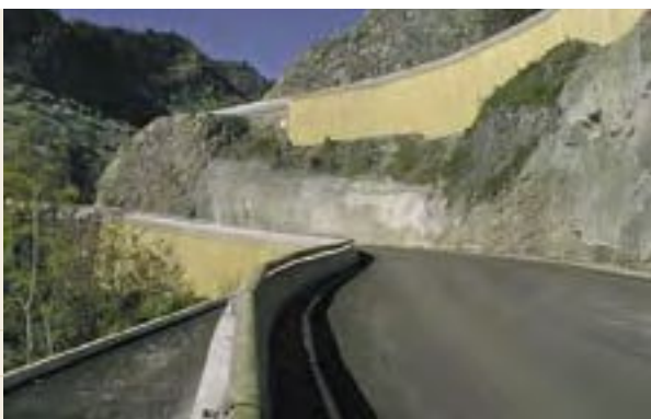
Photo 20 : remblais légers achevés
