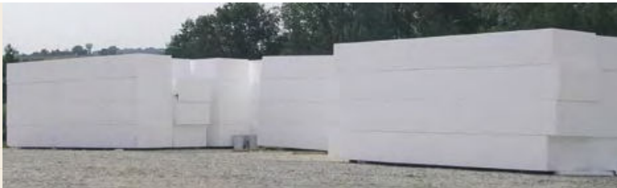
Photo 8 : stock de polystyrène expansé sur chantier
