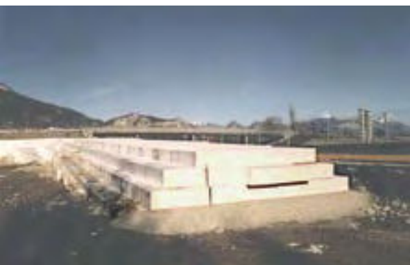
Photo et figure 1 : allègement d'un remblai sur sol compressible
