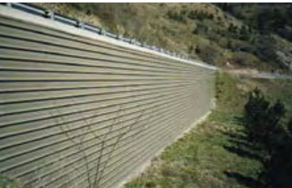
Photo 9 : parement en bardage métallique
