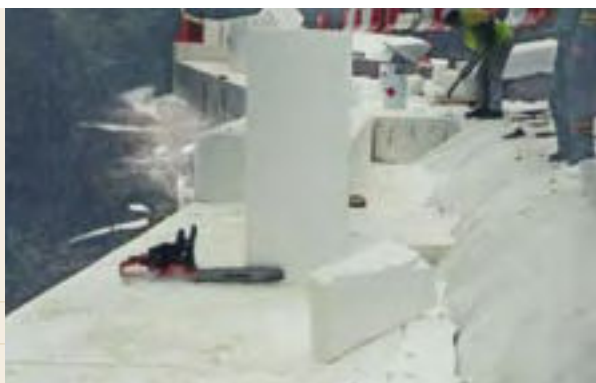
Photo 16 : remplissage arrière par chutes de polystyrène
