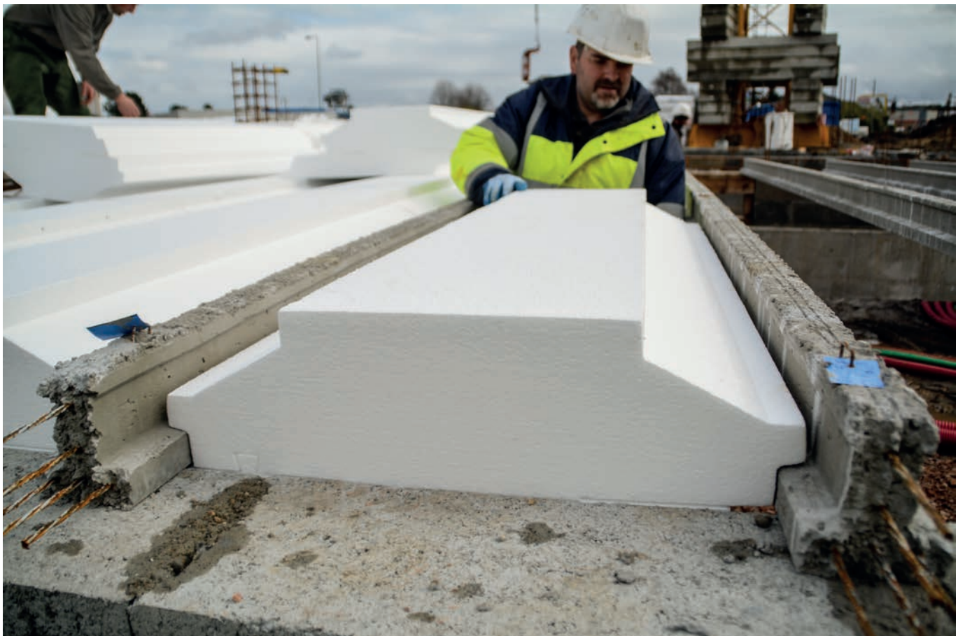
Exemple de poutrelle précontrainte
