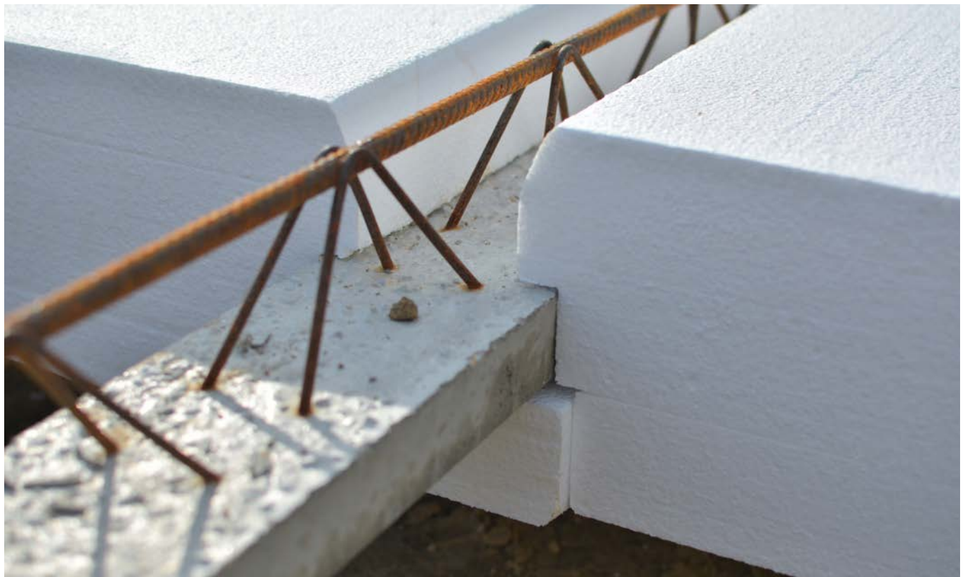
Exemple de poutrelle trellis
