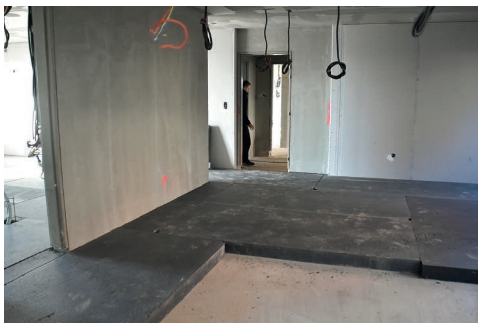
Pose de Solichape® Ultra en 120mm
