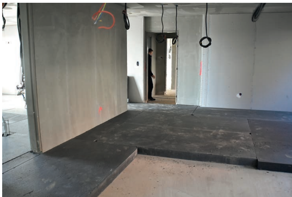
Pose de Solichape® Ultra en 120mm
