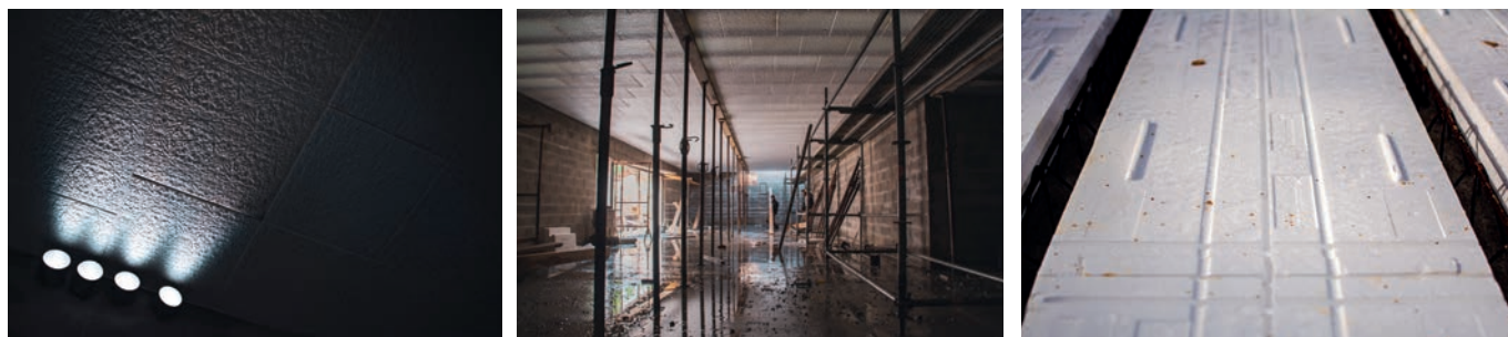
Chantier HIRSCH Isolation et IDF Planchers à Lamorlaye (60)
