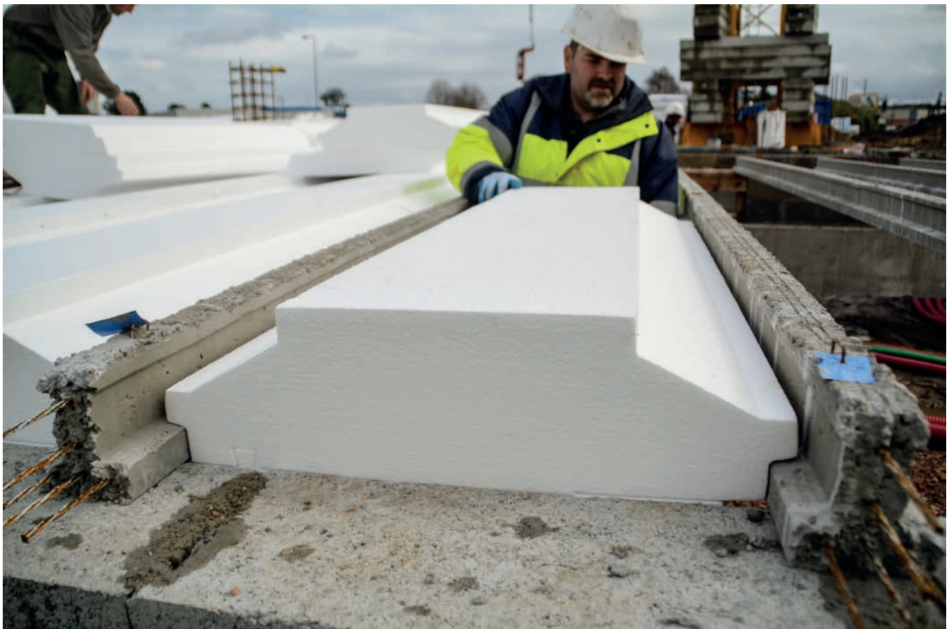
Exemple de poutrelle précontrainte
