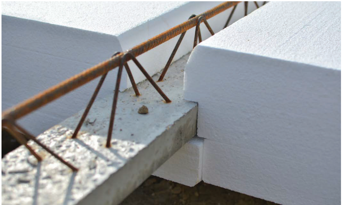
Exemple de poutrelle trellis
