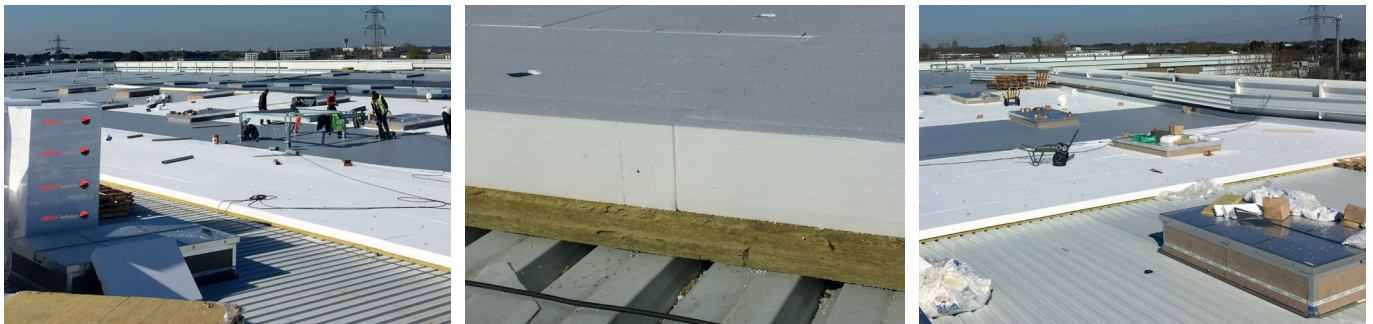
Système Stisolétanch® Protect posés par l'entreprise Airisol en Gironde (33)
