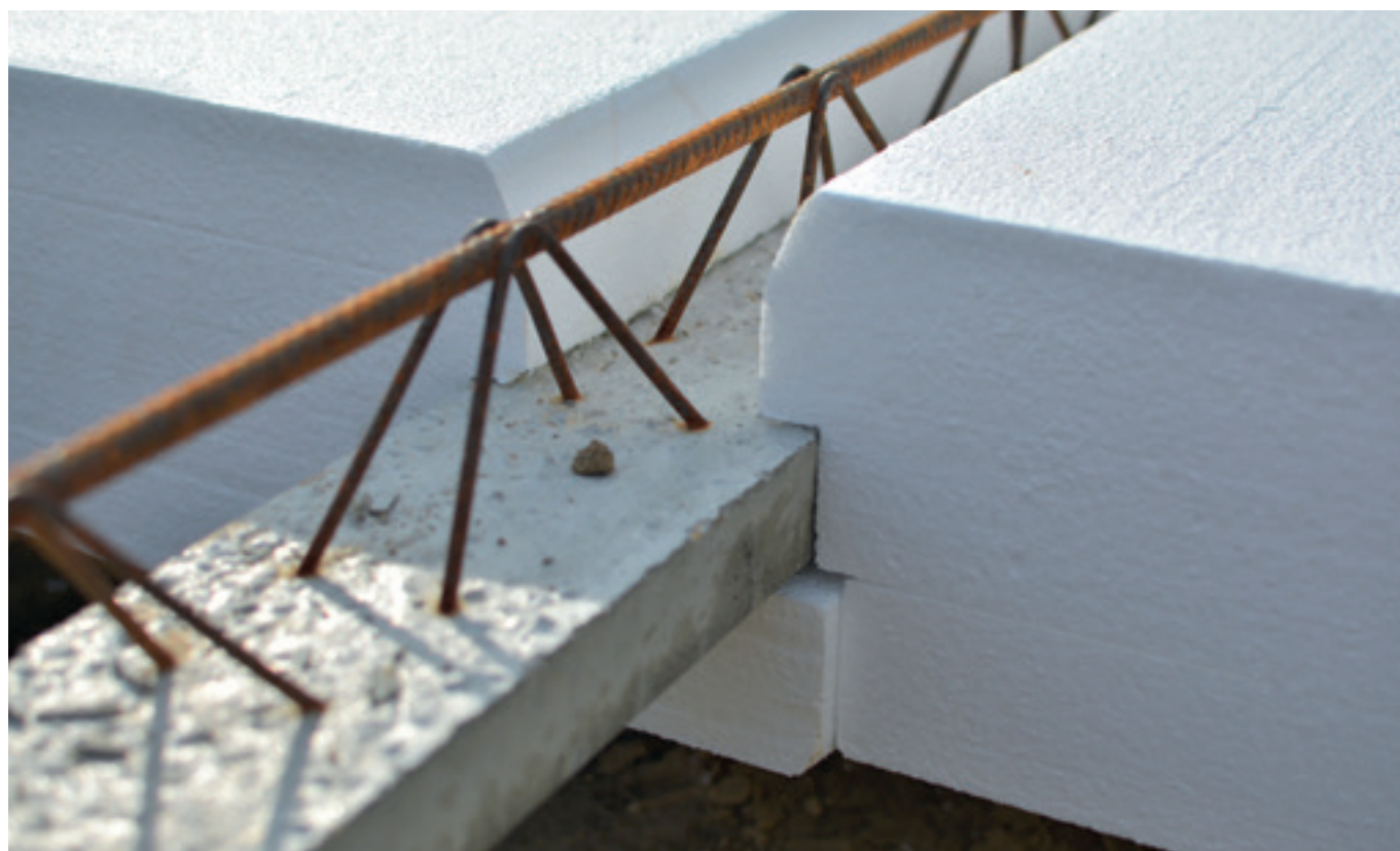
Exemple de montage sur poutrelle trellis
