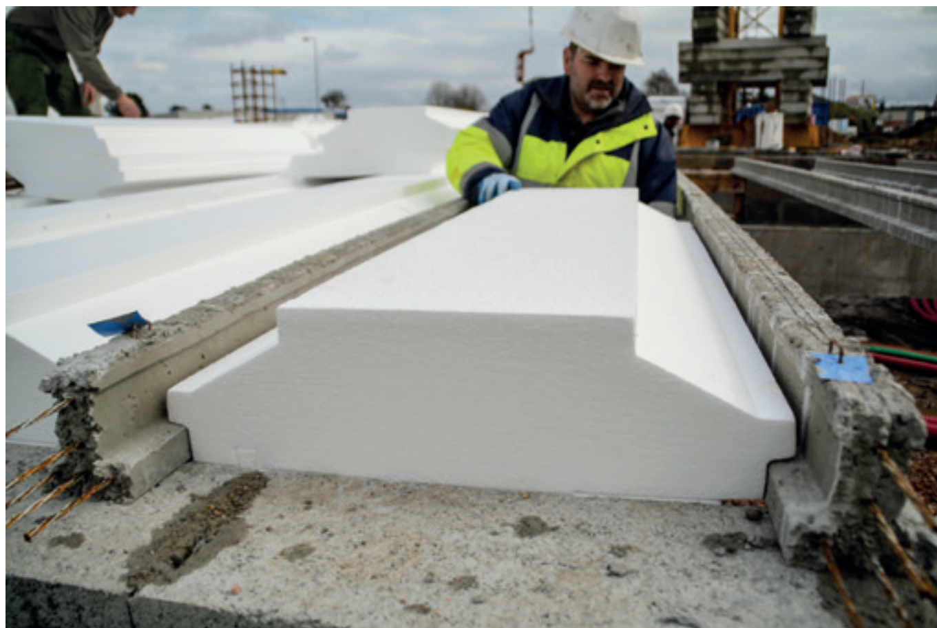
Exemple de montage sur poutrelle précontrainte
