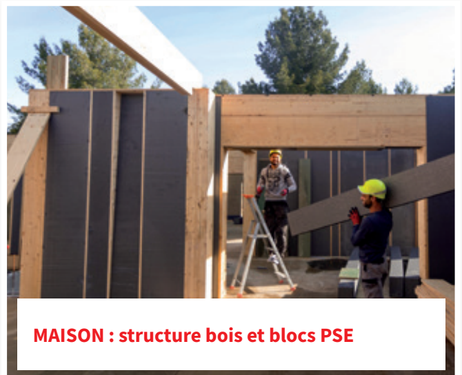
MAISON PASSIVE EN BLOCS PSE : Chantier Posytec à Gignat
