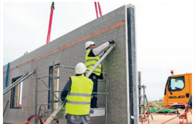
PRÉMURS : isolation intégrée des murs en béton - Chantier Soriba à Fontenay-le-Comte
