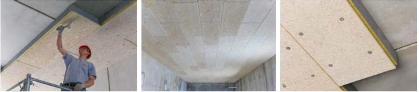
Panneaux Stisolith® Ultra LR Meca posés sur le chantier Le Parallèle à Courbevoie (92) par l'entreprise GCC
