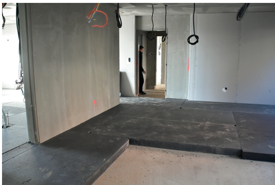
Pose de Solichape® Ultra en 120mm
