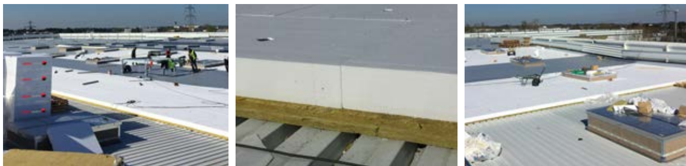
Système Stisolétanch® Protect posés par l'entreprise Airisol en Gironde (33)
