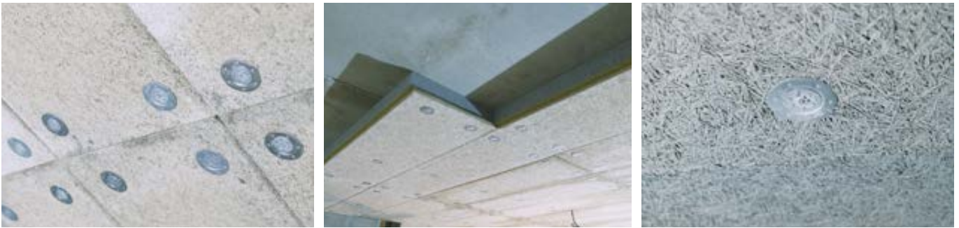
Panneaux Stisolith® Ultra G et Stisolith® Ultra LR Meca posés sur le chantier du Pôle de Santé à Falaise (40) par l'entreprise Ronco
