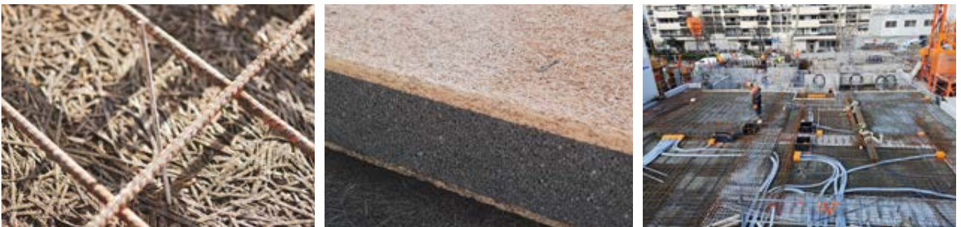
Panneaux Stisolith® Ultra Coffrage posés sur le chantier Résidence Unanime à Clichy (92) par l'entreprise Demathieu Bard
