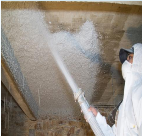
Isolation du plancher bas par flochage
