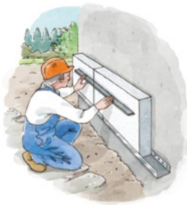
2 Vérifier la planéité de la pose à l'aide d'une règle.
